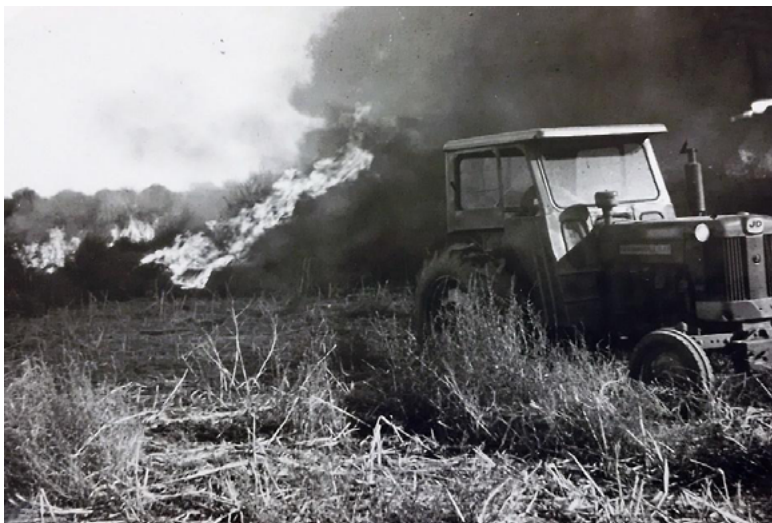
Foto 1.1 - Desmalezamiento del terreno donde se construiría el edificio del canal (1970). Fuente: Archivo de Canal 3-TVPP
