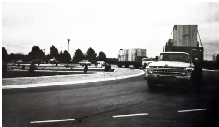
Foto 5.2 - Arribo de los equipos del canal a la ciudad de Santa Rosa (marzo de 1972). Fuente: Archivo de Canal 3-TVPP
