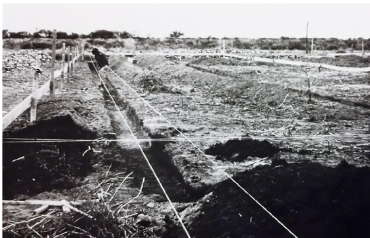
Foto 1.2 - Abriendo los cimientos para la construcción del edificio del canal (1970). Fuente: Archivo de Canal 3-TVPP
